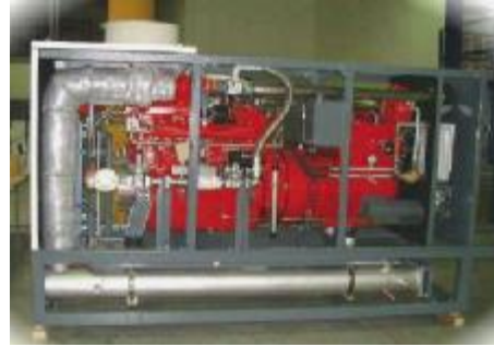
7.16.att. Nokomplektētas koģenerācijas stacijas vienības piemērs, ieskaitot virzuļdzinēju, mazu ģeneratoru, siltuma izmantošanas sistēmu, kas ievietoti akustiskā konteinerī
