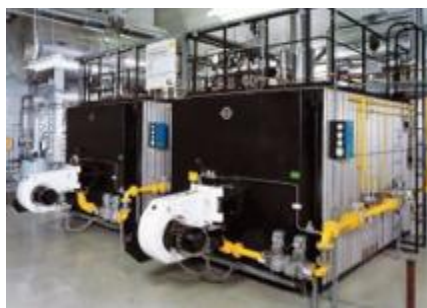
7.3.att. Uzņēmuma Danstoker ūdenssildāmais katls
